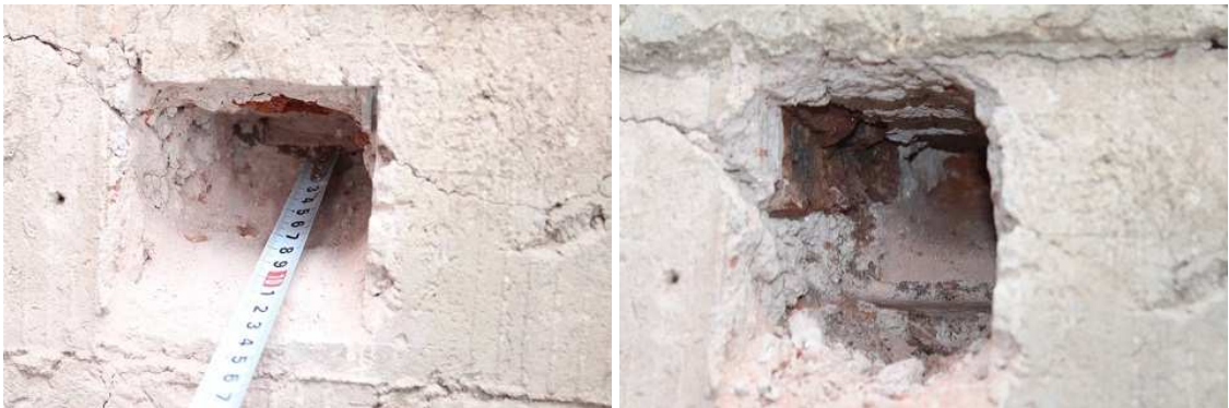
Cateo que muestra la bóveda de mampostería
